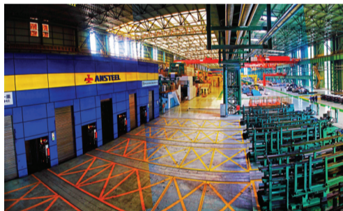
西昌钢铁板材厂酸轧产线。
