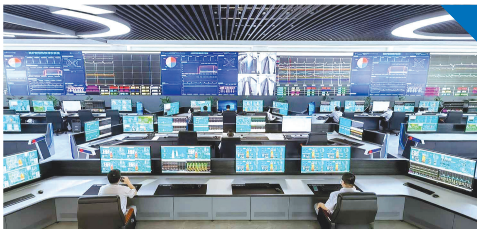
鞍钢股份炼铁集中控制中心。
